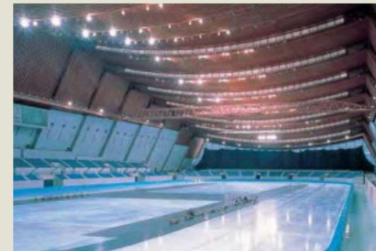
【長野市オリンピック記念アリーナ】播氏が構造設計を手がけた「長野市オリンピック記念アリーナ」。大断面集成材を用いた大規模建築物（混構造）で、この時に培われたノウハウが、「木造の大型建造物の技術を一般住宅へ」という思想を具現化し、後のSE構法へと結実していきました。
