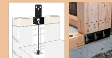
SE構法では、主要な柱の直下に柱脚金物を配し、柱と基礎とを堅牢に固定しています。柱脚金物は高強度なアンカーボルトにより、基礎に直接取り付けられるので、地震などの横からの力に強く、建物を支えます。
