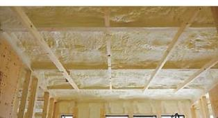
アクアフォームは硬質ウレタンフォームの特性を生かし水を使って発泡させます。オゾン層破壊や地球温暖化の原因となるフロンを全く使用しない、地球にやさしいウレタンフォーム素材として開発されました。アクアフォームは住宅の隅から隅まで家全体をすっぽり覆ってしまう現象を防ぐ発泡による断熱工事です。無数の細かい連続気泡で構成された硬質ウレタンフォームの特性を大いに發揮し、グラスウール10kgの約15倍の断熱効果を保持しています。また透湿性も低く断熱材内部に湿気を通しにくいため、壁体内の結露を抑制し、建物の耐久性を高めます。
